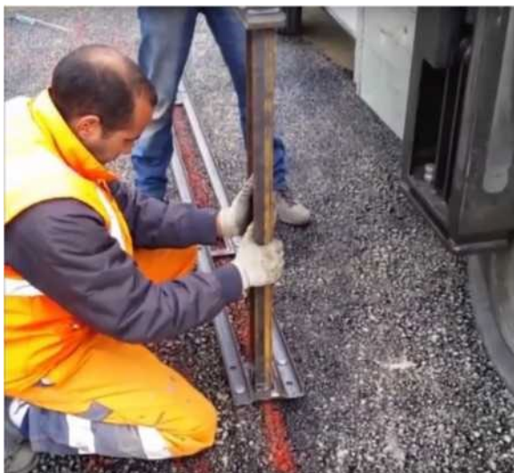
Fig. 8: Fastsättning av stolptypen IPE 80 med svetsad platta.
