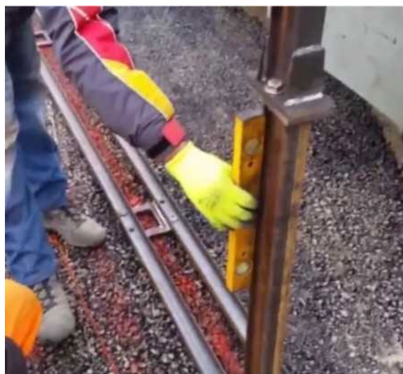
Fig. 10: Kontrollera med vattenpass.
