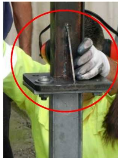
Fig. 9: Verktöget för stolpdrivning skruvas fast på stolpen.
