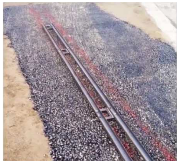
Fig. 7: Förberedelse av monteringsplattor med bormallen för SMA T2/SMA T4.
