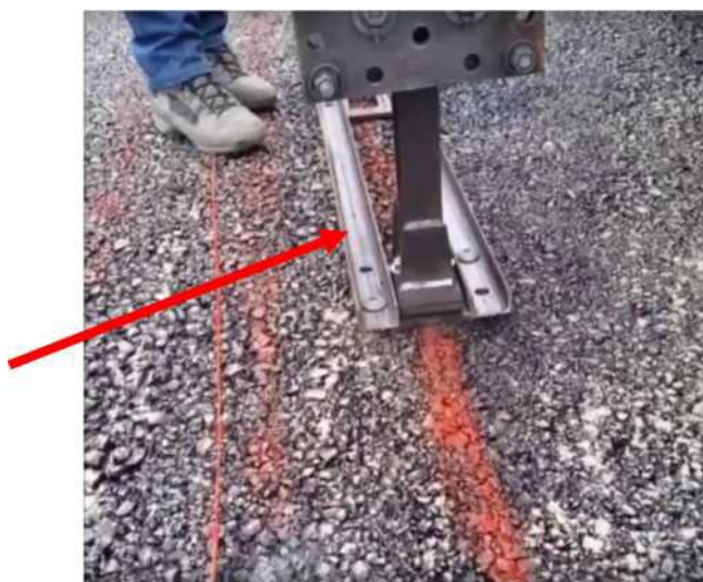
Fig. 11: Stolpdrivningen är slutförd.
